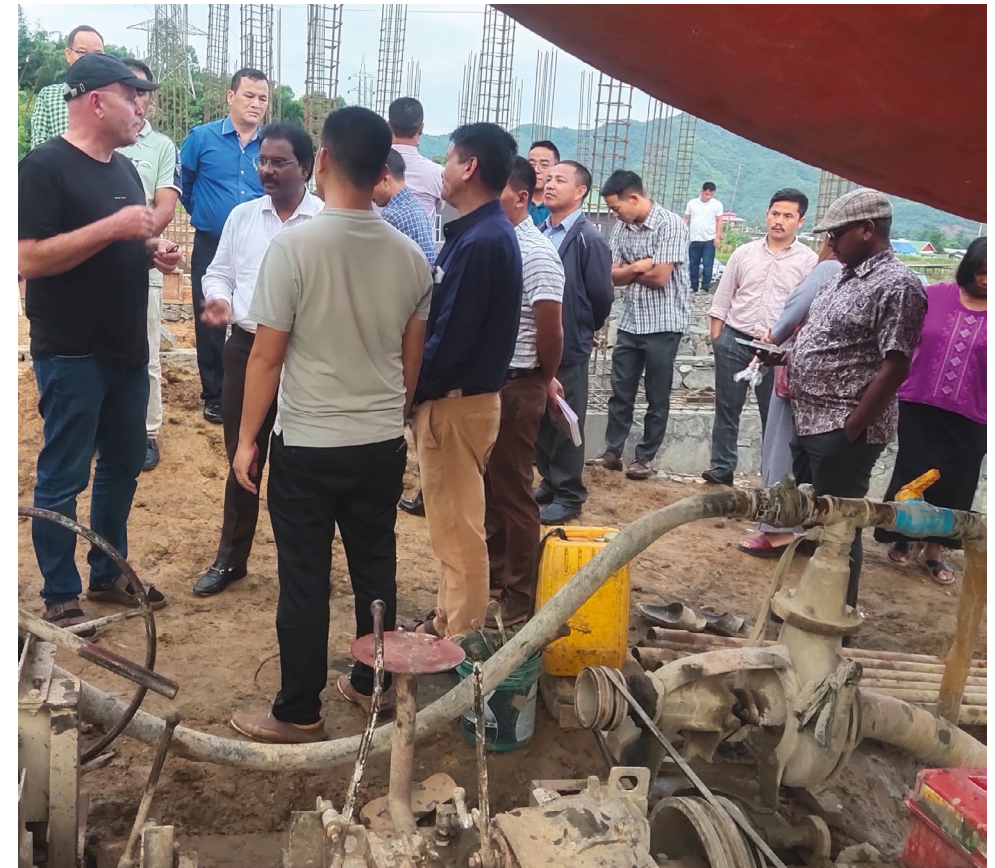
Øyvind Dovland forklarer hvordan vannanlegget fungerer.
